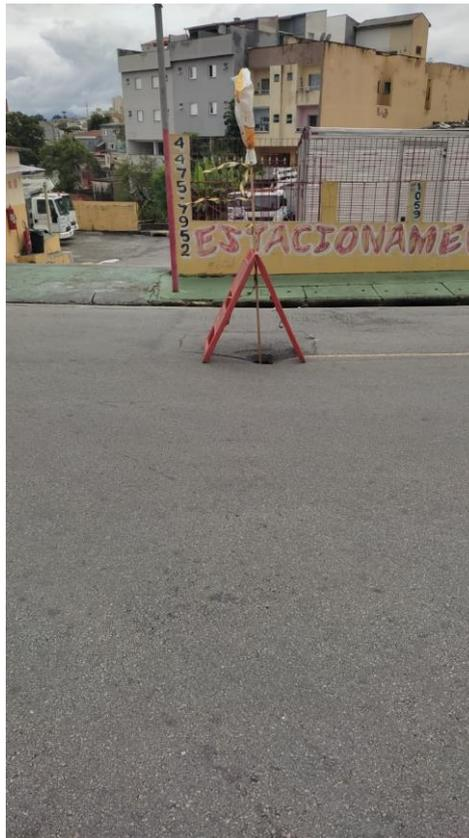
**JUSTIFICAMOS** o pedido tendo em vista a existência de buraco com afundamento do solo na via pública, causando danos nos veículos e acidentes no local.
