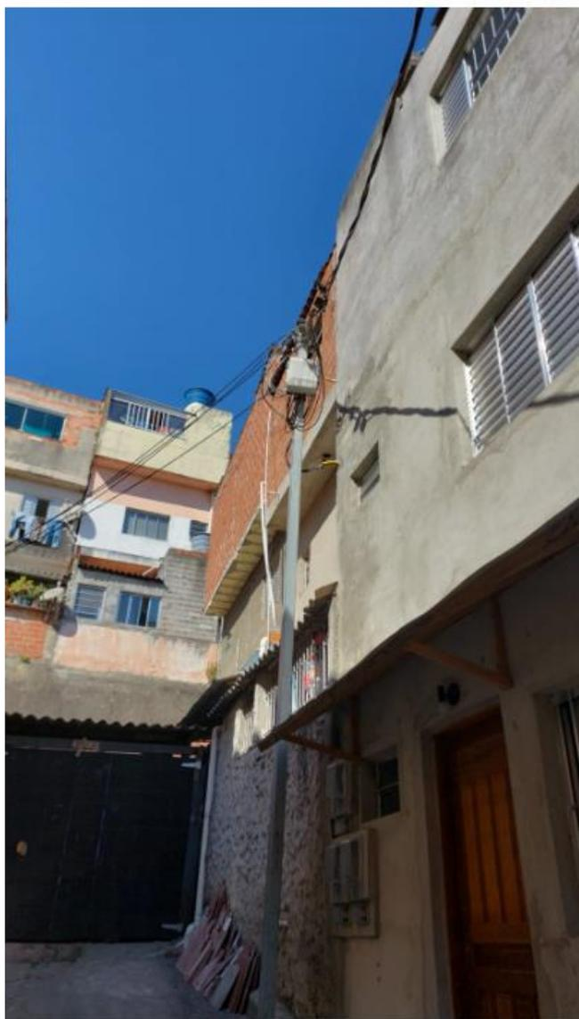
Na travessa Pindaí, 86 existe um poste de energia elétrica, porém é necessário colocar um braço nele para que a via possa ter iluminação pública.
